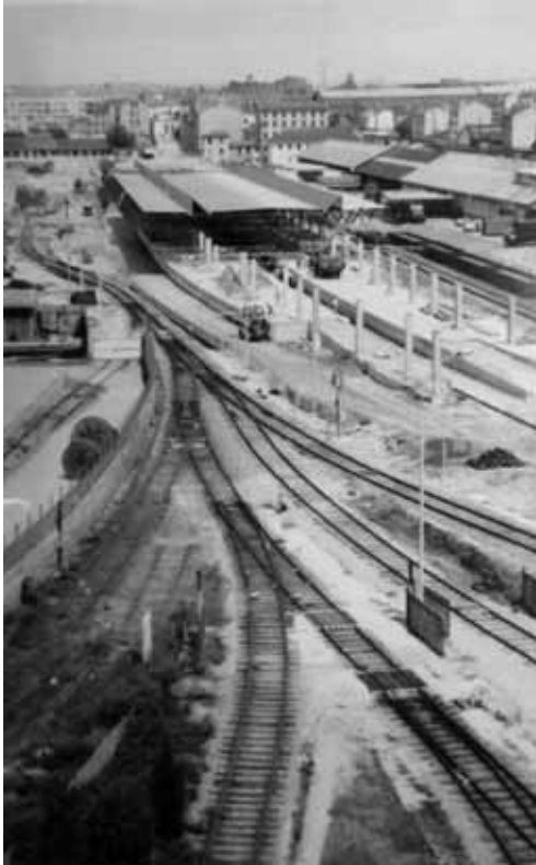
Zone pendant la construction de la gare postale à Lyon en 1984
